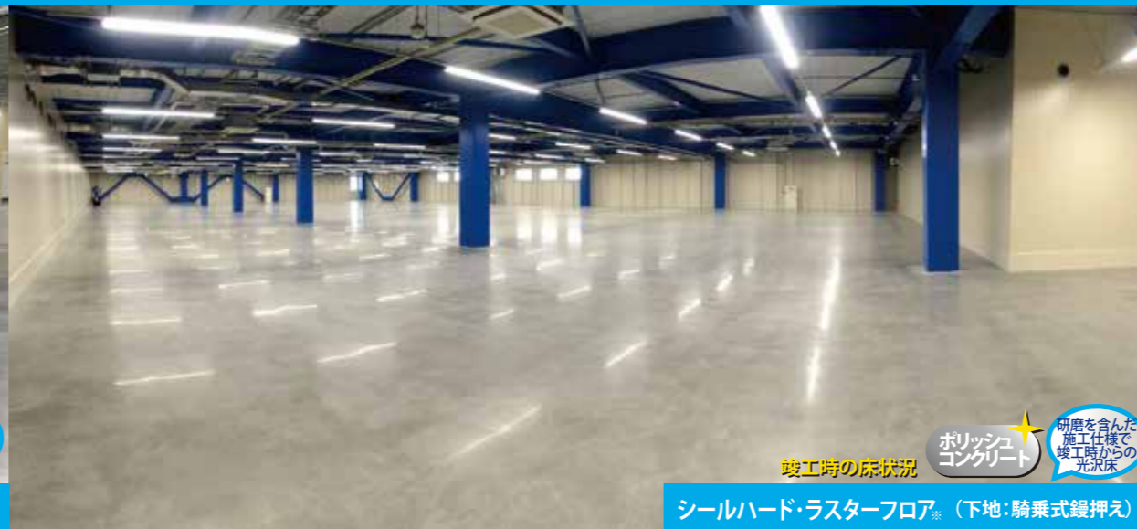
竣工時の床状況 ポリッシュ コンクリート 研磨を含んだ 施工仕様で 竣工時から 光沢床 シールハード・ラスターフロア※(下地:騎乗式鍍押し)
