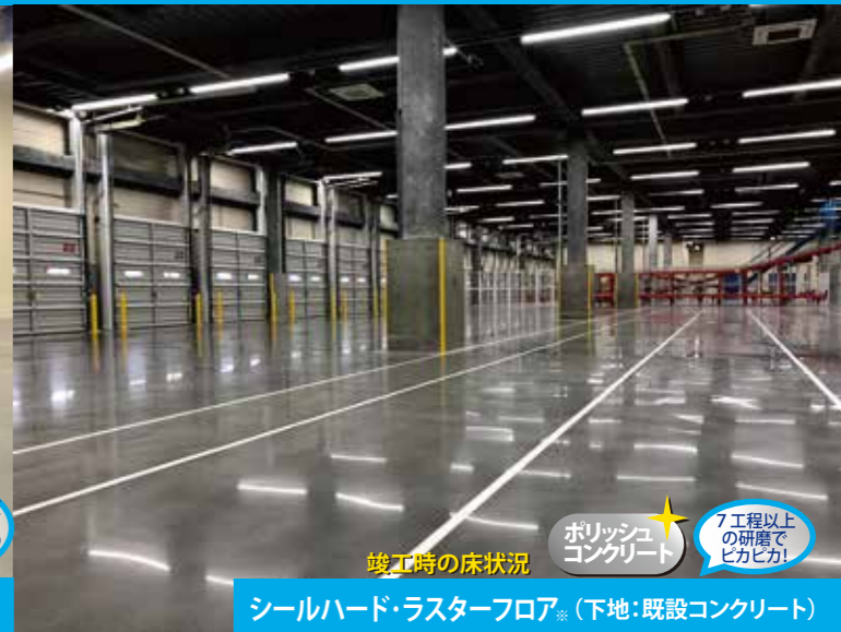
竣工時の床状況 ポリッシュ コンクリート 研磨を含んだ 施工仕様で 竣工時から 光沢床 シールハード・ラスターフロア※(下地:騎乗式鍍押し)
