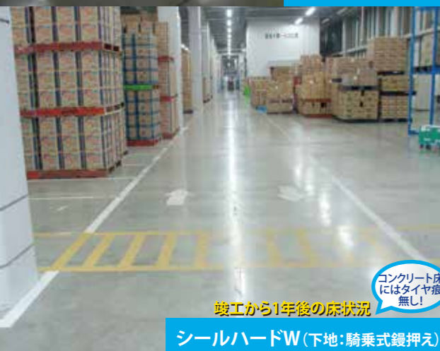
良い下地と 毎日のスクラパー 洗浄でビカビカ に成長 竣工から 6年後 の床状況(冷蔵倉庫) シールハードW(下地:騎乗式鍍押し)
