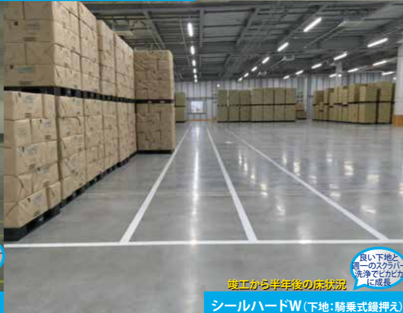
竣工時の床状況 ポリッシュ コンクリート 研磨を含んだ 施工仕様で 竣工時から 光沢床 シールハード・ラスターフロア※(下地:騎乗式鍍押し)
