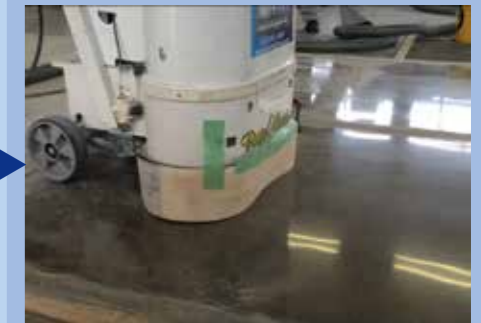
仕上研磨(艶出し) #800~#3000 (2~3工程)
