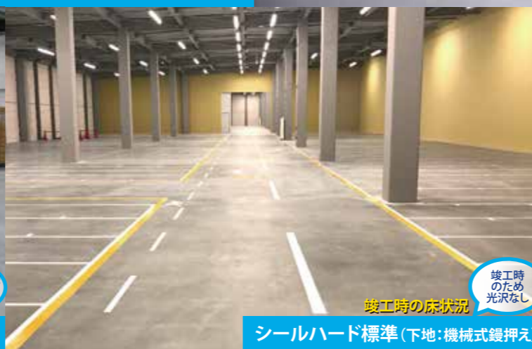
良い下地と 週一のスクラパー 洗浄でビカビカ に成長 竣工から 半年後 の床状況 シールハードW(下地:騎乗式鍍押し)
