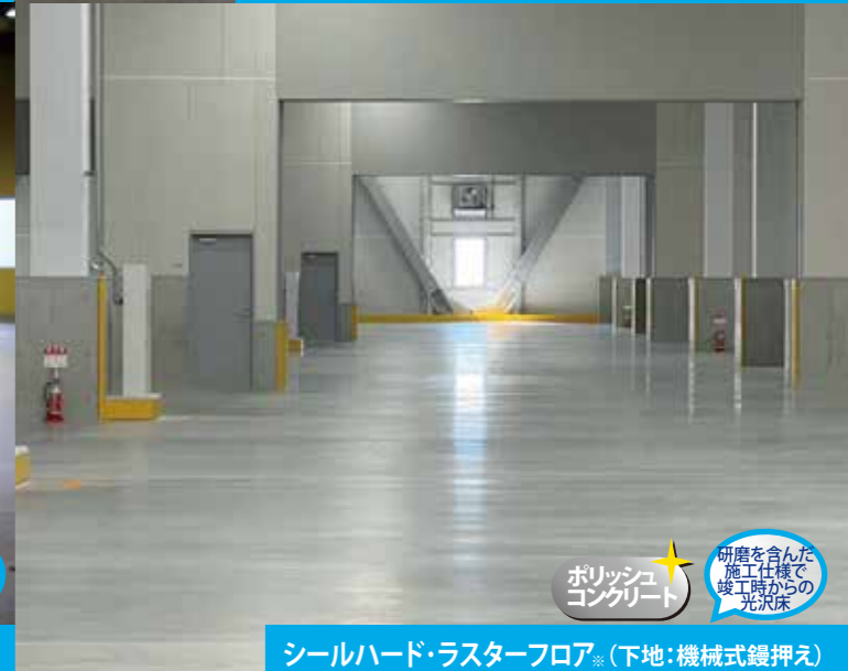
竣工時の床状況 ポリッシュ コンクリート 7工程以上 の研磨で ビカビカ! シールハード・ラスターフロア※(下地:既設コンクリート)
