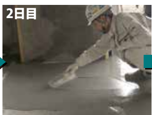
流し込み打設
