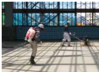
E-CON 使用により打設～初期水和反応時の温度上昇を抑えます。
